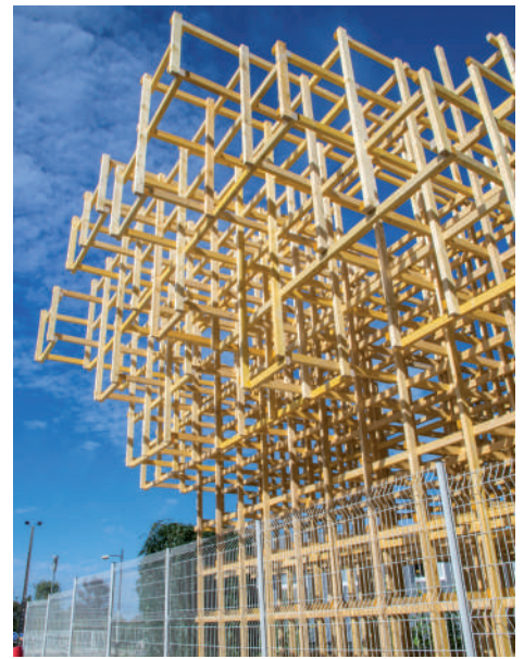
Encorbellement côté extérieur (jour).
