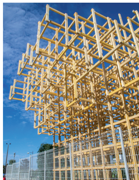
Encorbellement côté extérieur (jour).
